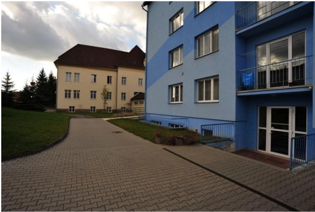
Budova výcvikového CHB (vlevo) a hlavní budova DOZP
