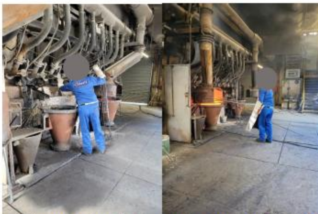
Obrázek 1: Odpich šachtové pece
