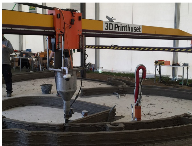
Obr. 21 Tisknutí domu pomocí 3D tisku [39]
