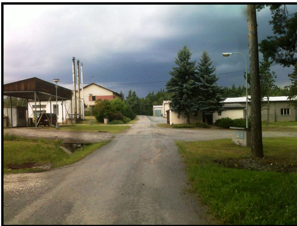
Obr. 5: Pohled do průmyslového areálu společnosti Arboles na území Plzeň 9-2/4
