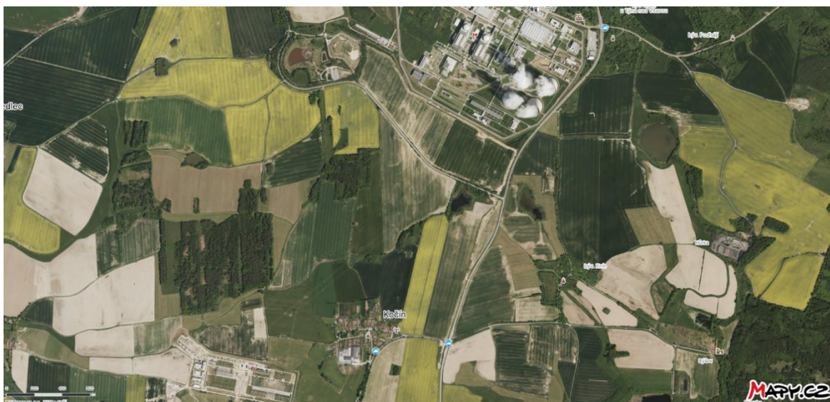
Obrázek č. 14: Letecký snímek jaderné elektrárny Temelín a rozvodny Kočín [38]
