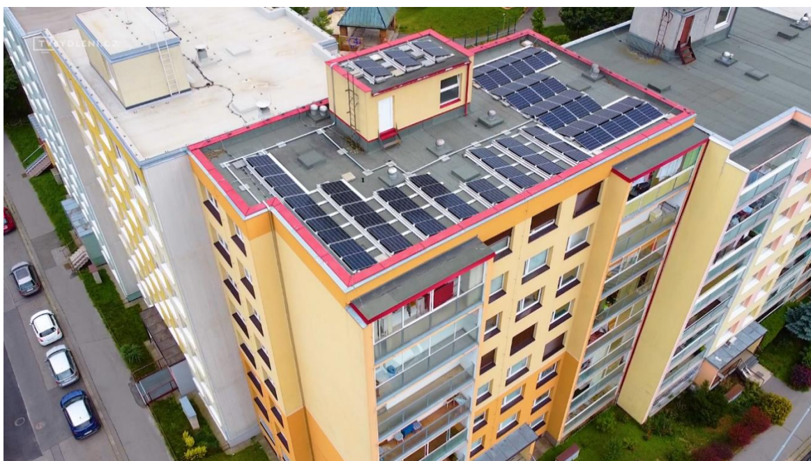
Obrázek 1 - Příklad panelového domu s nainstalovanou fotovoltaickou elektrárnou (8)
