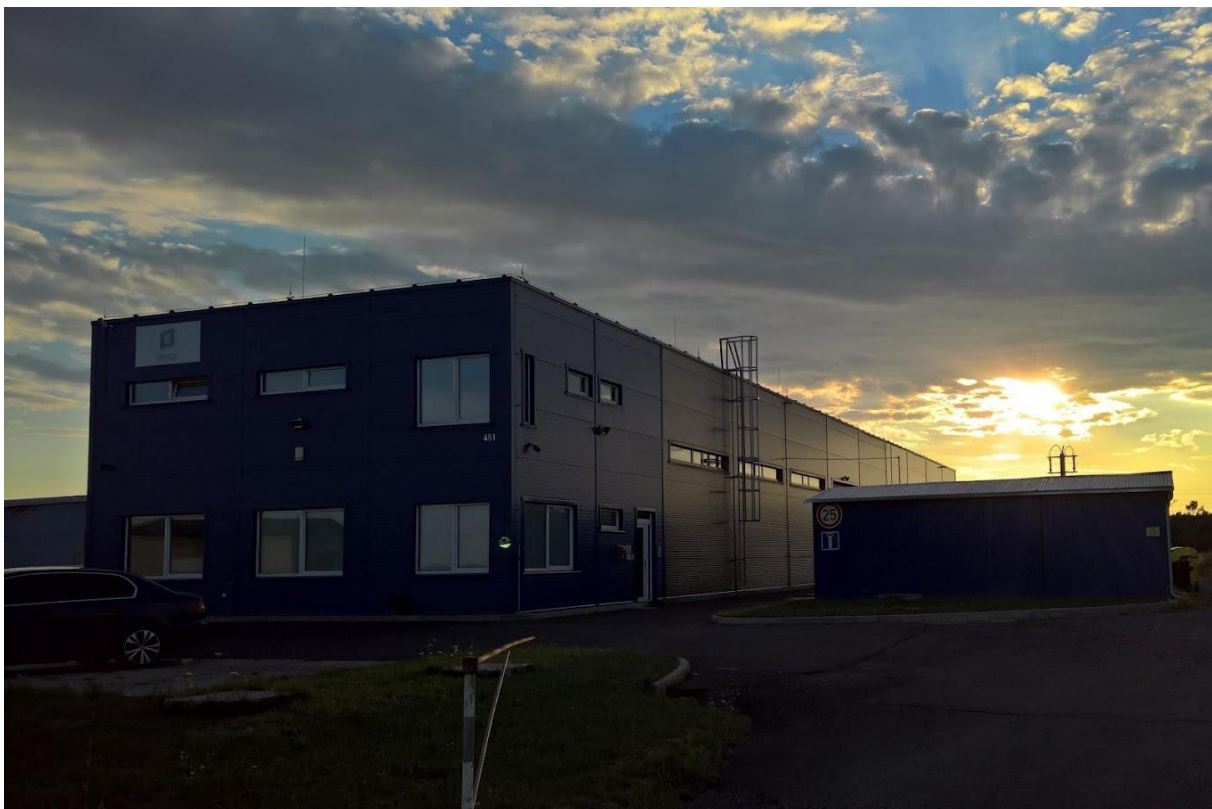
Obr. 2-1 Sídlo společnosti Infer s.r.o. [17]
