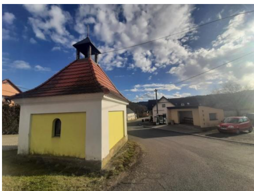
Obr. č. 54 – Fotografie: Příšov – kaple u zastávky; zdroj: vlastní
