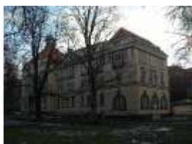
Obr. č. 12: Další budovy školy
