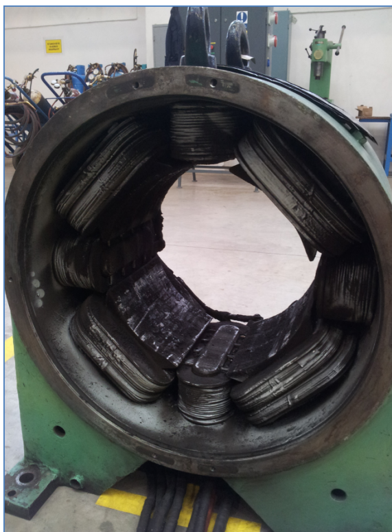
Obr. 3: Ukázka znečištěného statoru motoru
