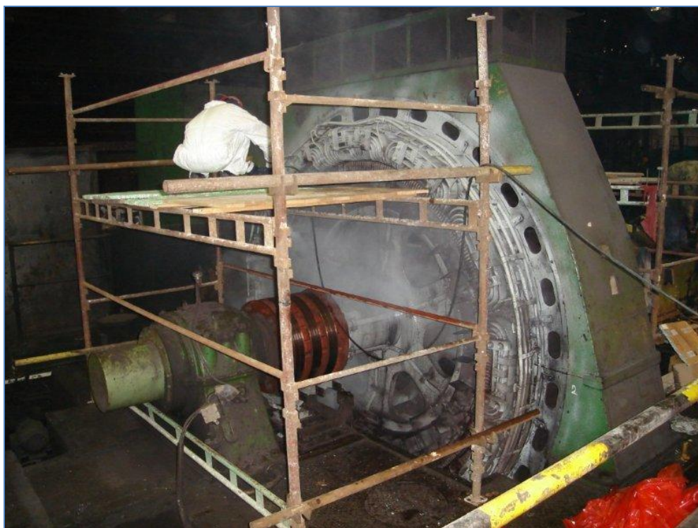
Obr. 8: Čištění generátoru Orlík 2002 LARS Chemie s.r.o.
