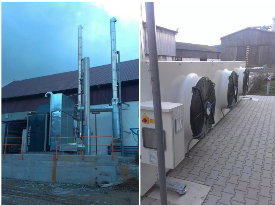
obr. 11: Zleva - ORC jednotka v reálném umístění a napojením na výfuky od motorů KGJ; přilehlé chlazení ORC jednotky
