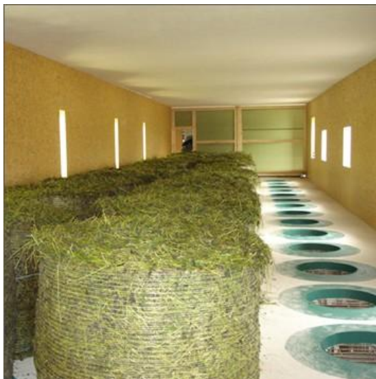
obr. 13: Vnitřek haly s teplovzdušnými kanály pro sušení balíků; převzato z [13]
