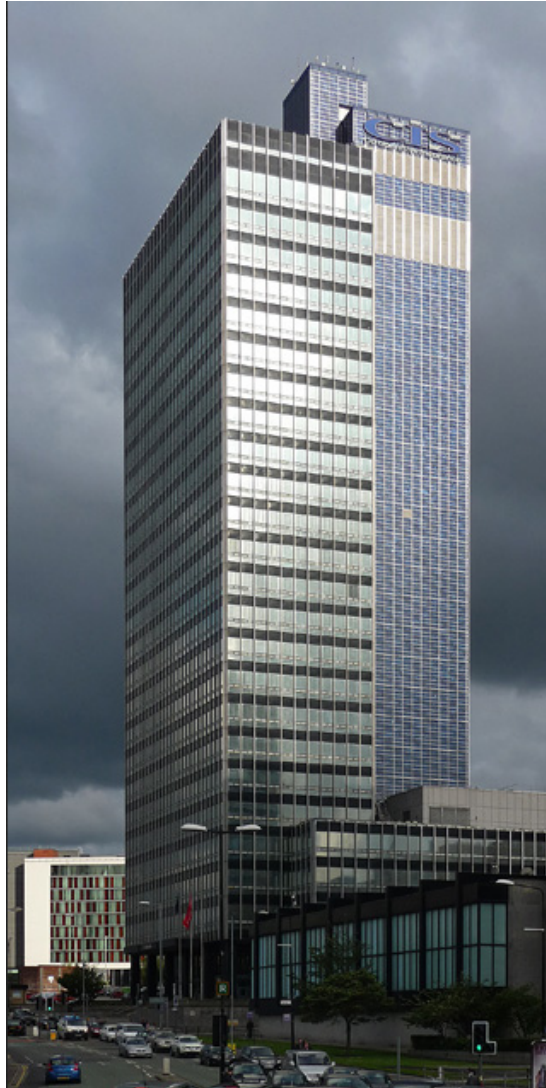
Obr. 7 CIS Tower Manchester - budova, kde při stavbě byly využity CIS články (převzato z [21])
