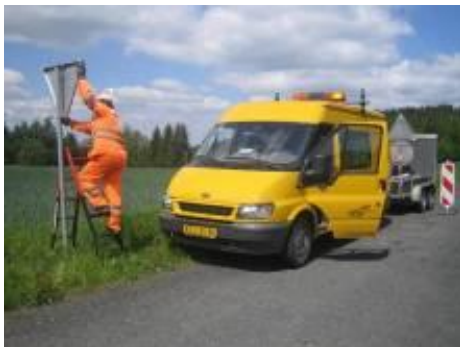
Obrázek 6: Údržba svislého dopravního značení
