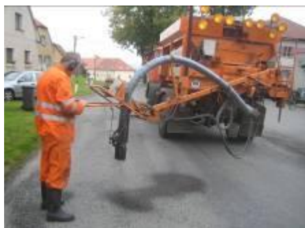
Obrázek 5: Opravy a výspravy tryskovou metodou Turbo-asfaltovou emulzí
