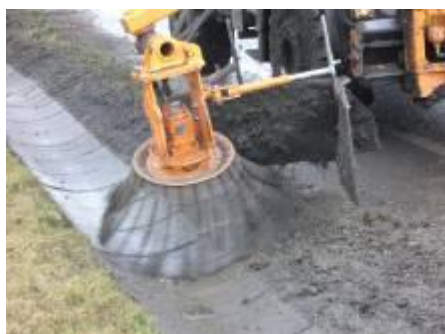
Obrázek 8: Čištění příkopů
