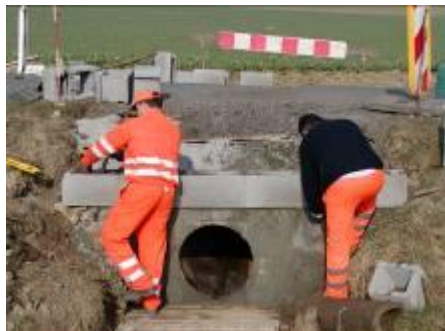
Obrázek 9: Údržba propustku
