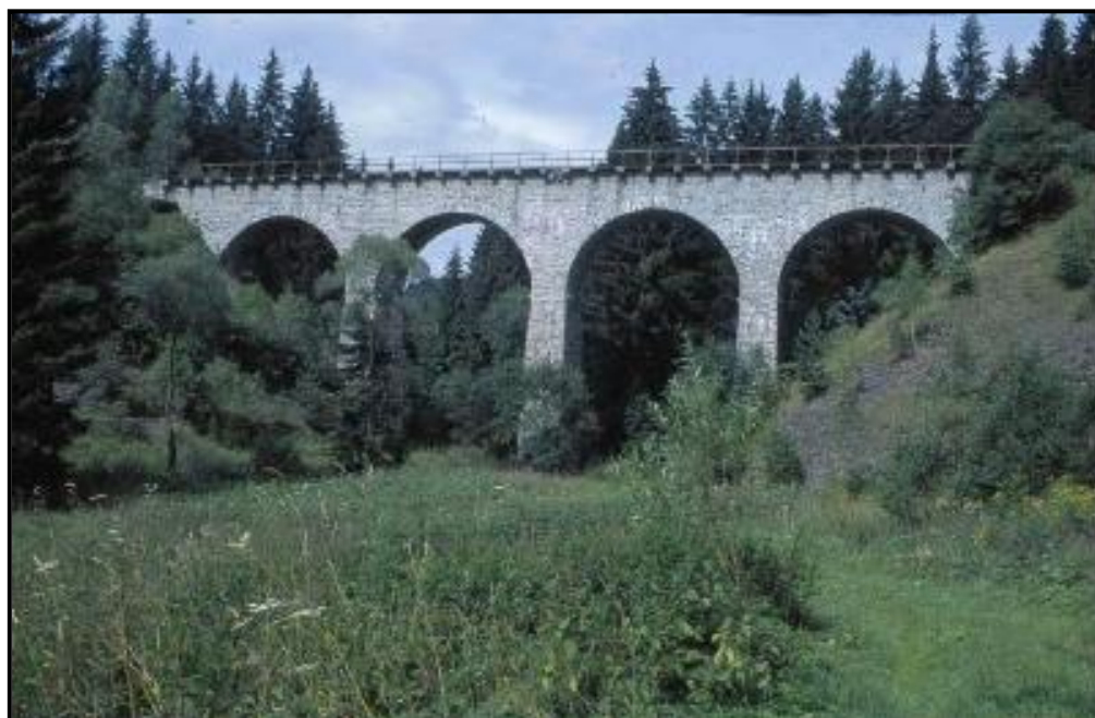
Obr. č. 8: Klášterní viadukt
