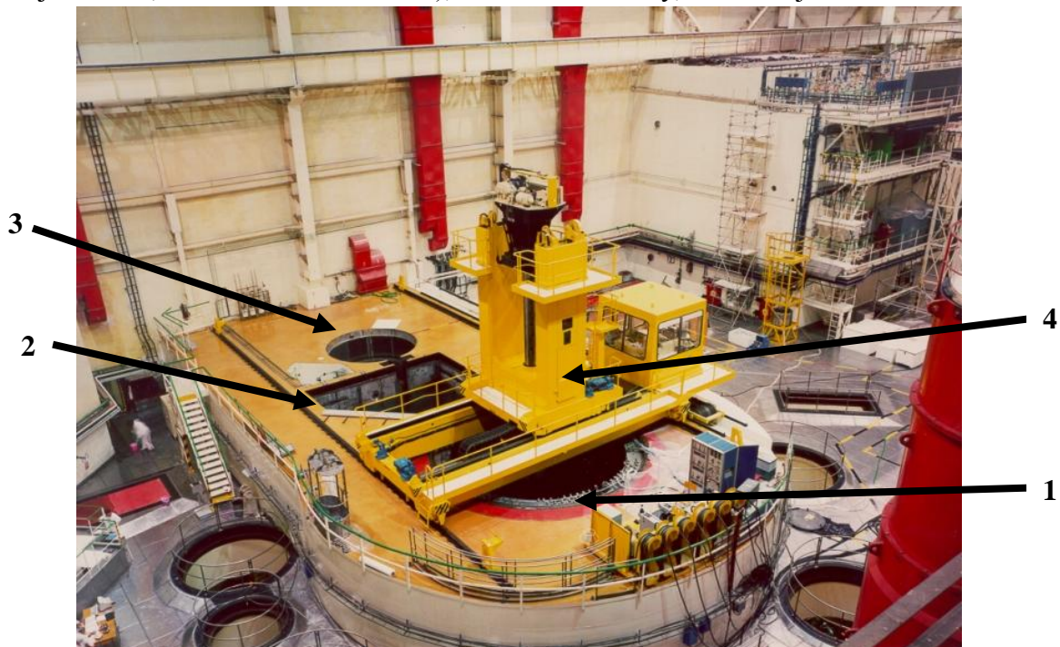
Obrázek 2.3 – Pohled na šachtu reaktoru (1), BSVP(2), šachtu pro transportní kontejner (3) a zavážecí stroj (4) v JE Dukovany [33]
