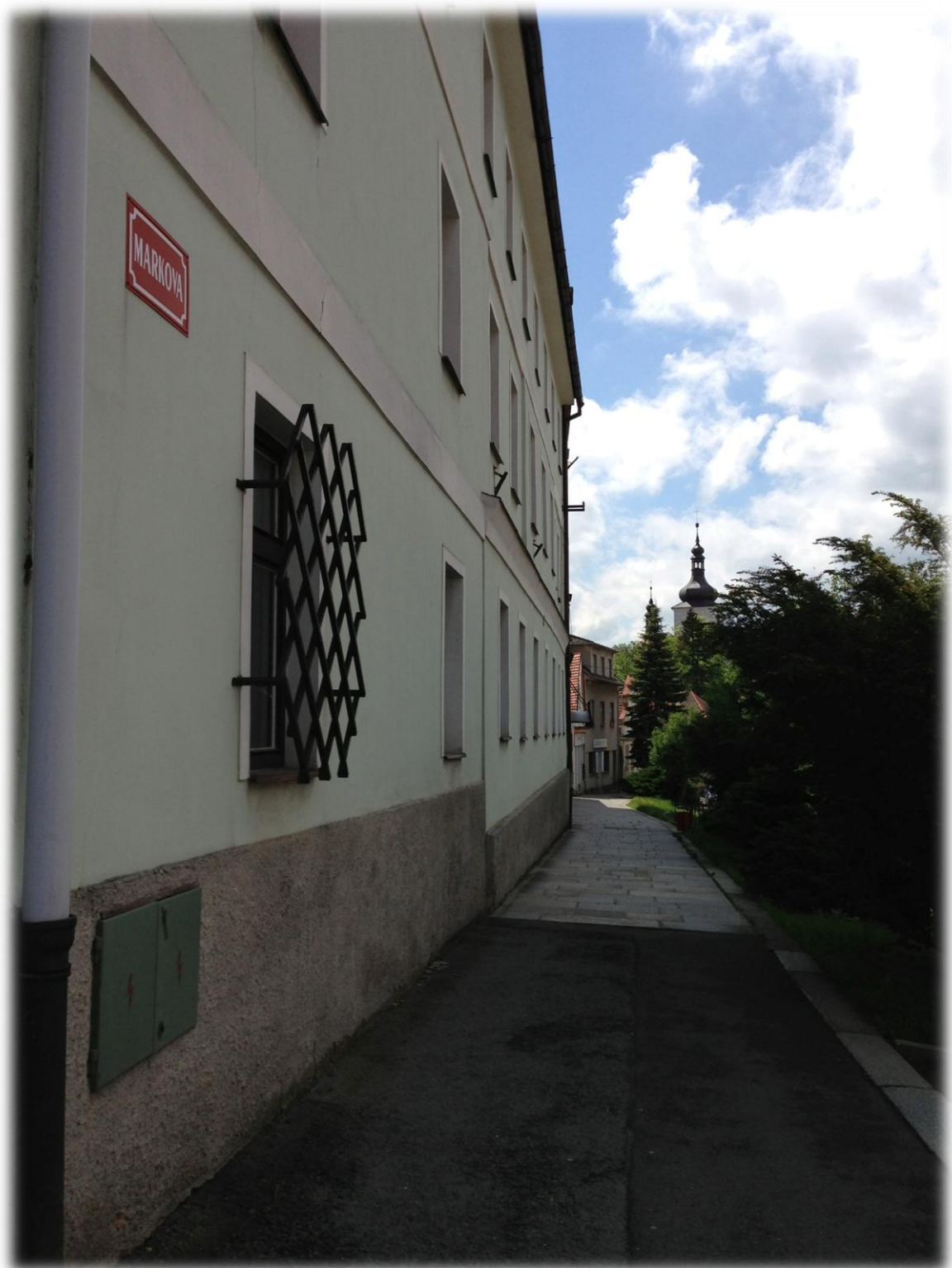
Pohled Markovou ulicí směrem ke kralovickému kostelu. (Foto Pavel Beneš, 2013.)
