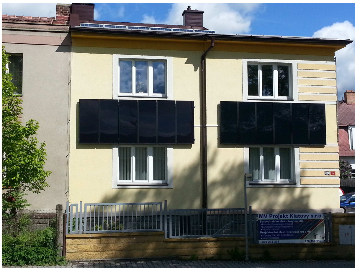
Obr. 1. 15 fasáda domu č.p. 326
