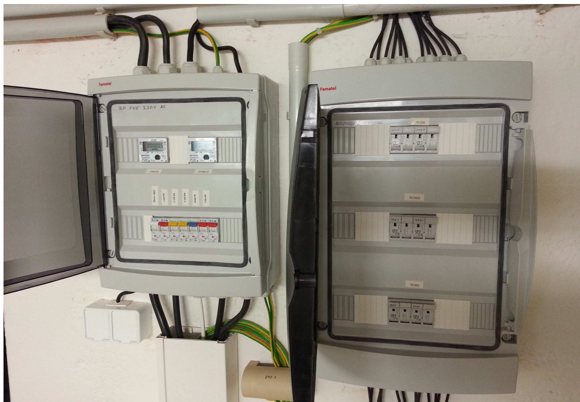
Obr. 1. 18 Rozvaděč AC a DC
