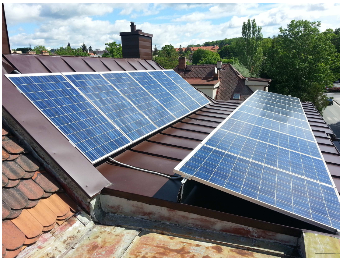
Obr. 1. 16 Střecha domu č.p.326
