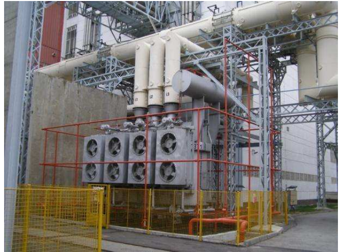
Obrázek 7 - Rezervní transformátor
