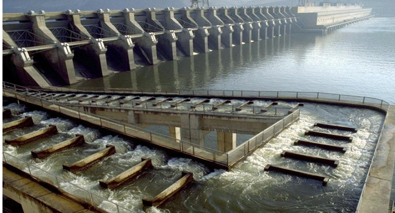
Obr. 11: Rybí přechod na vodním díle John Day Dam na řece Columbia
