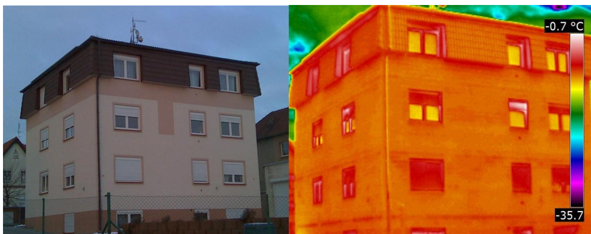
Obr. 3.8: Celkový pohled na budovu
