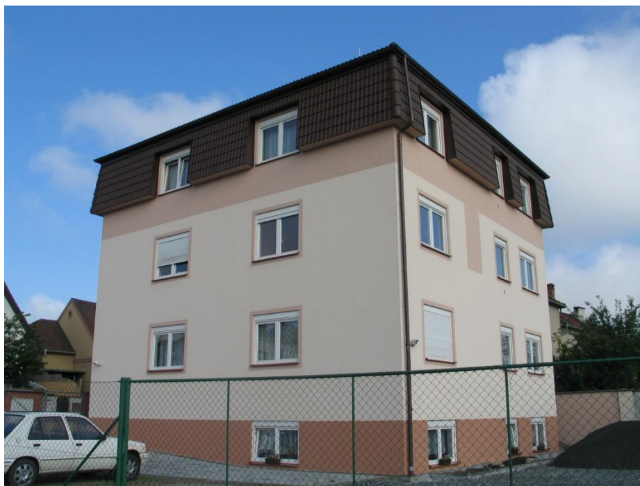
Obr. 3.1: Celkový pohled na budovu
