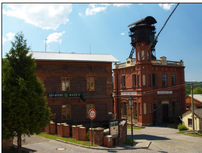
Součástí areálu příbramského muzea je i budova Ševčínkého dolu, pocházející z roku 1813. (Foto: autor 2011)
