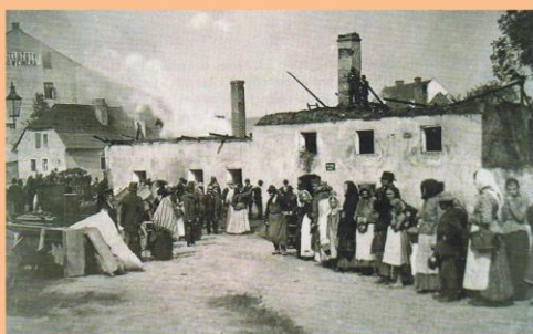
Na Příkopech - dříve
