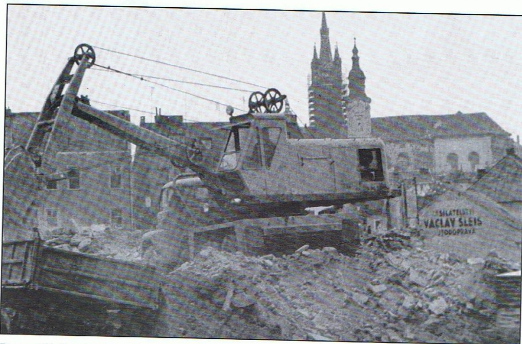
Demoliční práce na Rybníčkách v roce 1975.
