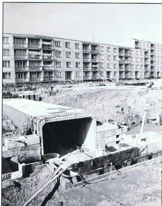
Stavba podchodu v Plzeňské ulici. Snímek byl pořízen 26. září 1978. (b)
