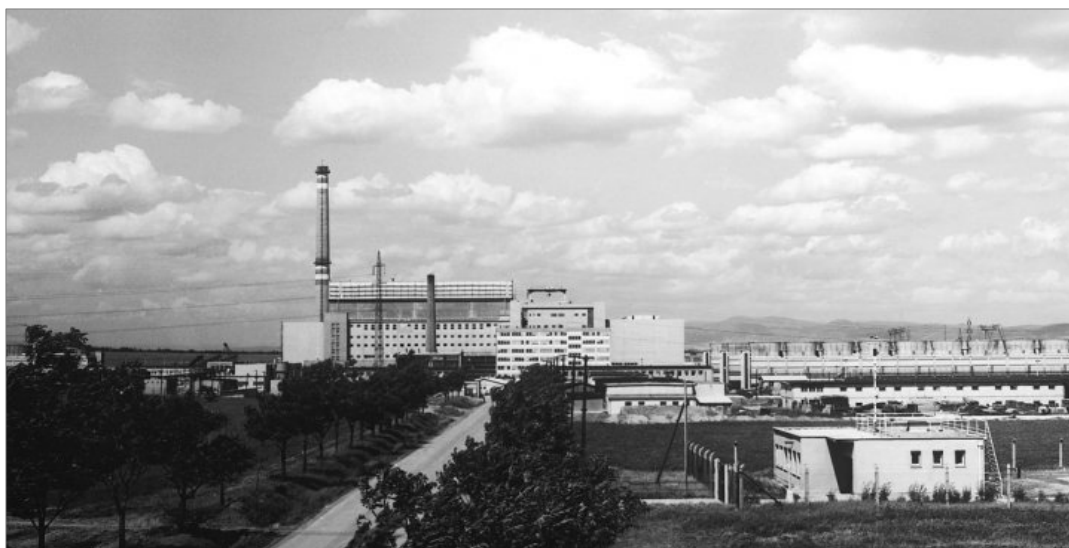
Obr. č. 4: Jaderná elektrárny A1 – Jaslovské Bohunice
