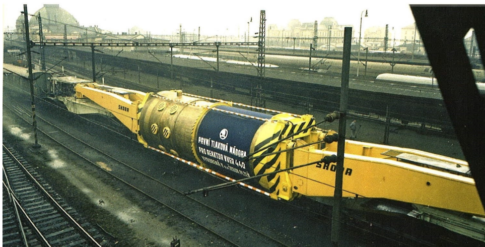
Obr. č. 9: Přeprava první tlakové nádoby reaktoru VVER 440 na staveniště v Jaslovských Bohunicích. Rok 1980.
